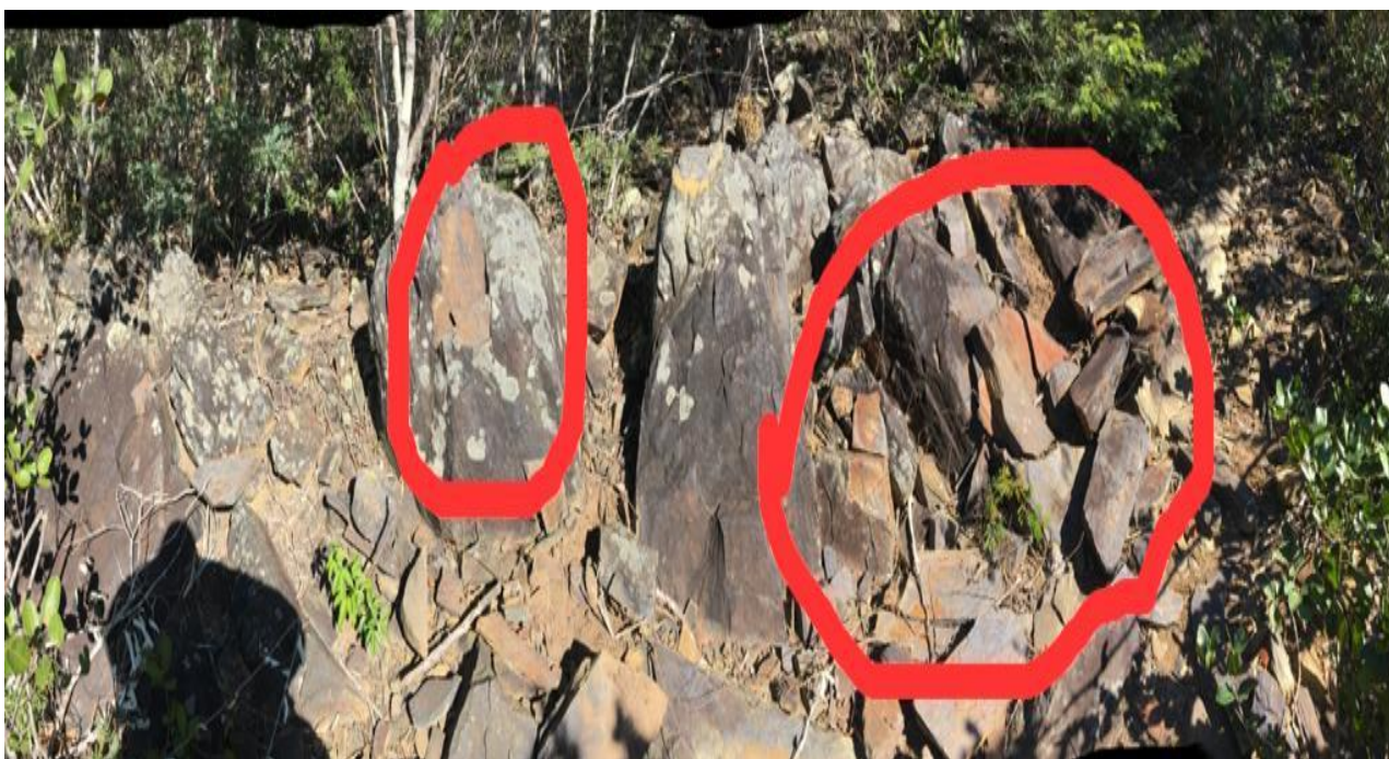
4 - Marcas de pedras quebradas dentro da propriedade.
